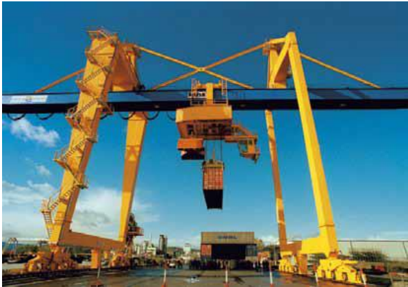
Abbildung 5- Brückenkrane im Hafen Krems (Quelle: Mierka Donauhafen Krems)
